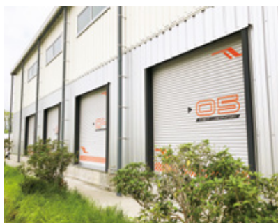
「ロボットスケートパーク」が内部に構築されているATRのロボット実験棟の外観
